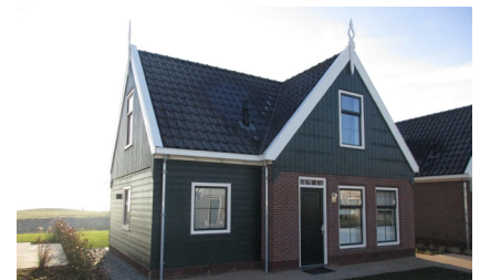
Alternatief materiaal voor hout: Werzalith (onderhoudsvrij)
