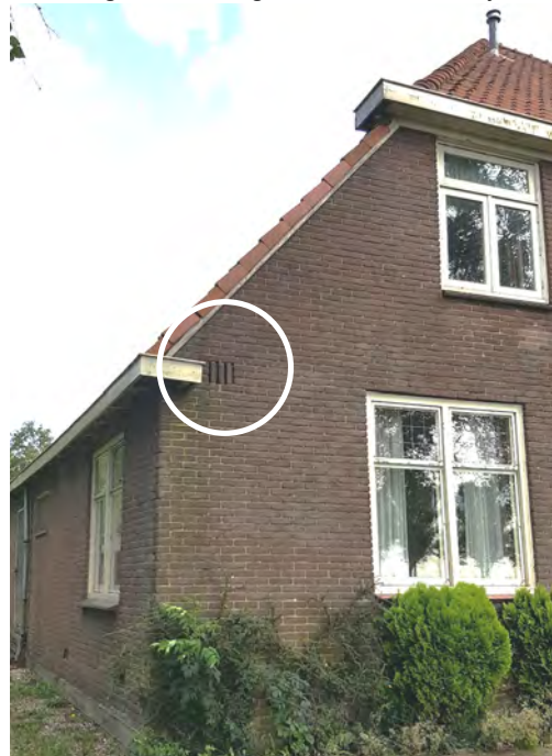
Afbeelding 13. Het woongedeelte van de boederij heeft een spouw en open stootvoegen (zie cirkel)
