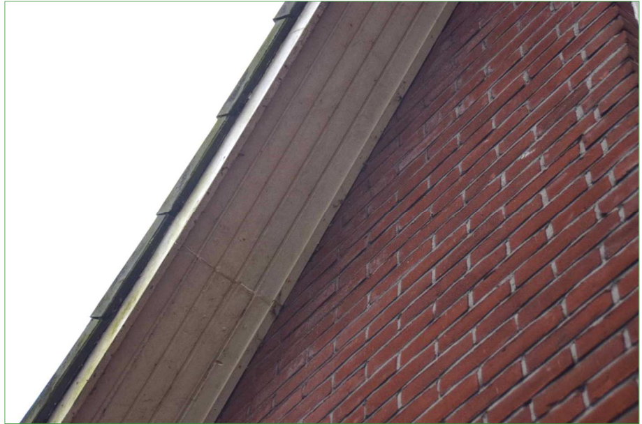
Lat tussen muur en daklijst om inkruipen van vleermuizen tegen te gaan.
