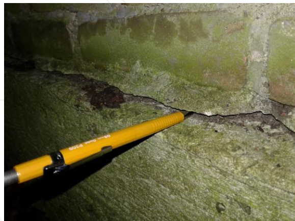
Fundering linker gevel is onder metselwerk gevel uitgezakt.
