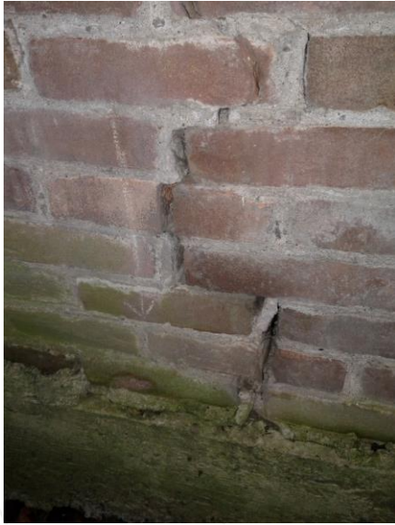
Linkergevel, metselwerkgevel is in het midden gebroken.
