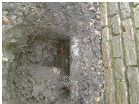
Metselwerkfundering voor en rechterzijgevel
