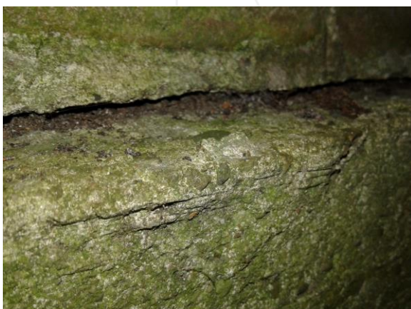
Fundering linker gevel is onder metselwerk gevel uitgezakt.
