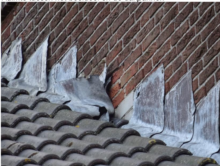
Ruimte tussen het dak en de muur
