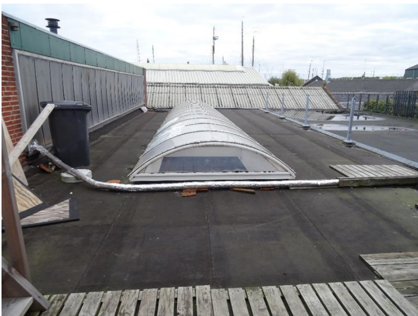
Dak van één van de panden aan Noordeinde 80-86
