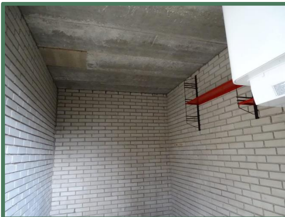
Binnenzijde voormalige opslag plangebied
