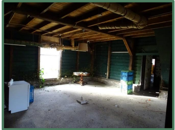
Binnenzijde begane grond voormalige opslag
