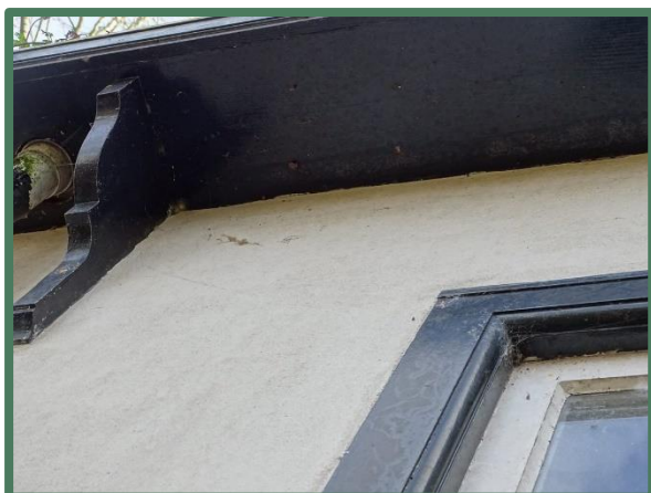
Aansluitende dakrand oude woondeel
