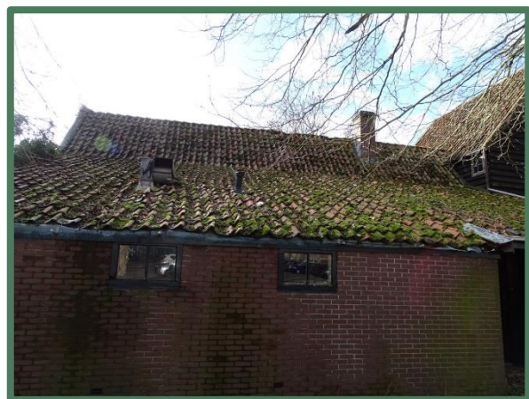
Overzicht oostzijde nieuwe woondeel
