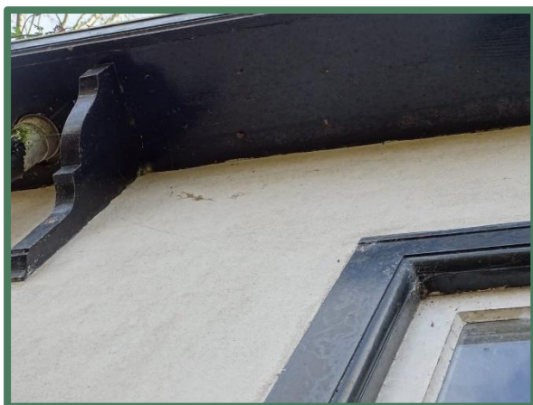
Aansluitende dakrand oude woondeel
