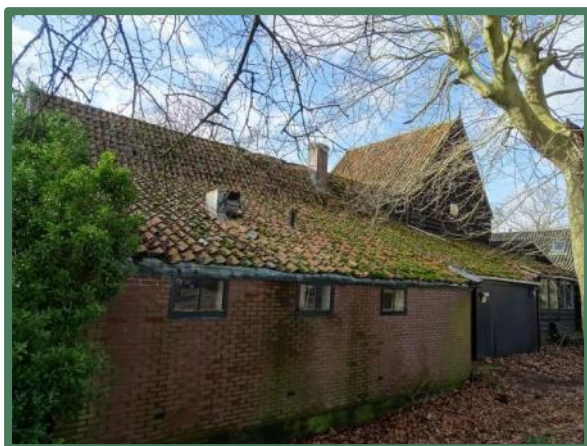
Overzicht zuidoostzijde nieuwe woondeel en opslag
