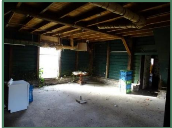
Binnenzijde begane grond voormalige opslag
