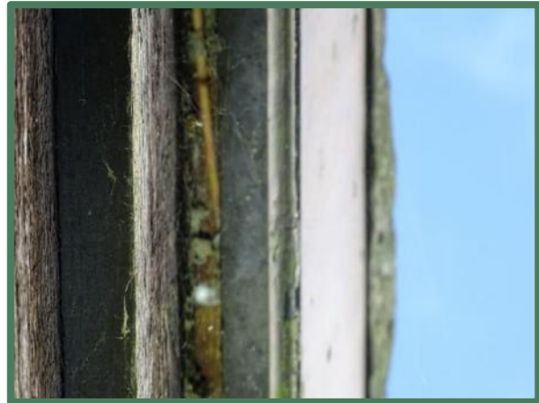
Aansluitende planken en bouschuim onder de dakrand opslag
