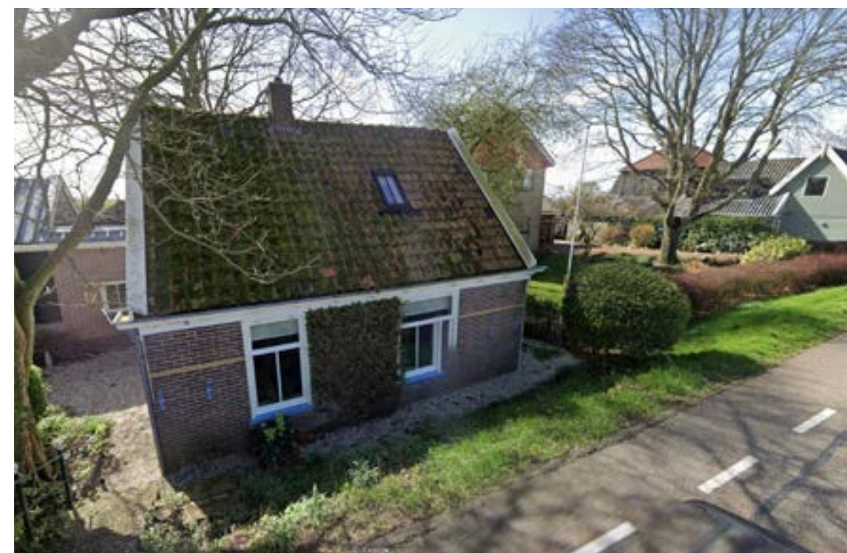
Monickendammerrijweg 47 woonhuis aan de de dijk (verdiept)
