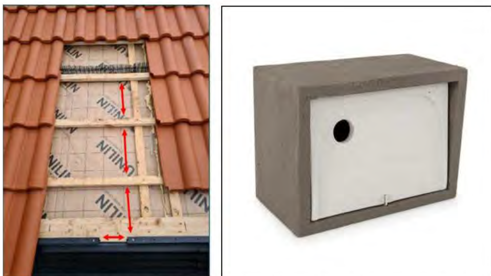
Figuur 4: Vogelschoot onder de vierde rij dakpannen (links, bron: OZHZ) en inbouwneststeen voor de huismus (rechts, bron: Vivarapro).
