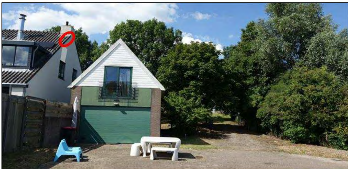
Figuur 6: De locatie van de kantpan waar het zomerverblijf van de gewone dwergvleermuis zich bevindt in het huis van de buren.
