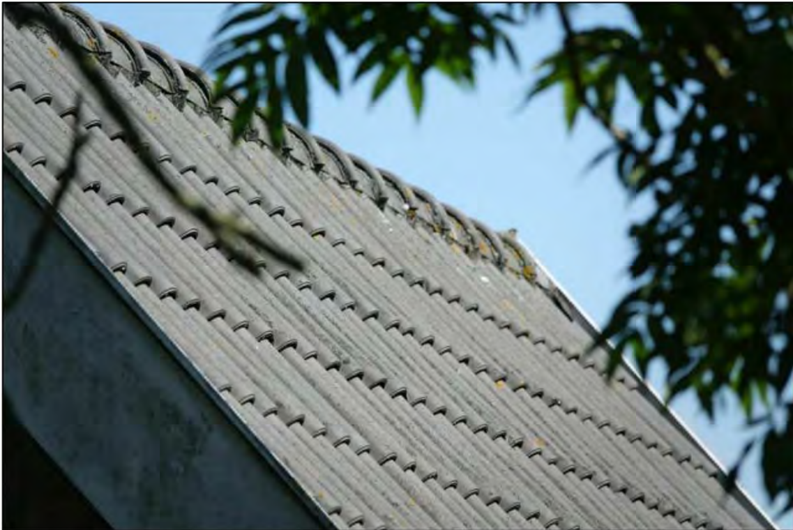
Figuur 9: Alle dakpannen liggen recht en de nokpannen zijn dichtgemaakt waardoor beschermde soorten geen verblijf of nest kunnen hebben onder de dakpannen.
