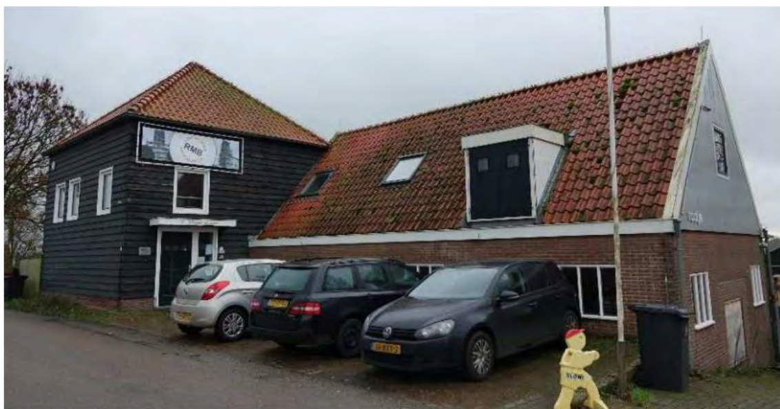
Figuur 2: Opstallen aan de noordzijde van het perceel
