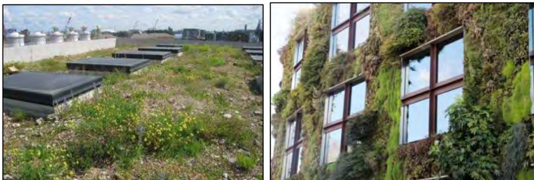
Figuur 7: Bruin dak (links bron: checklist groen bouwen) en groene gevel (rechts bron: groenkennisnet.nl).
