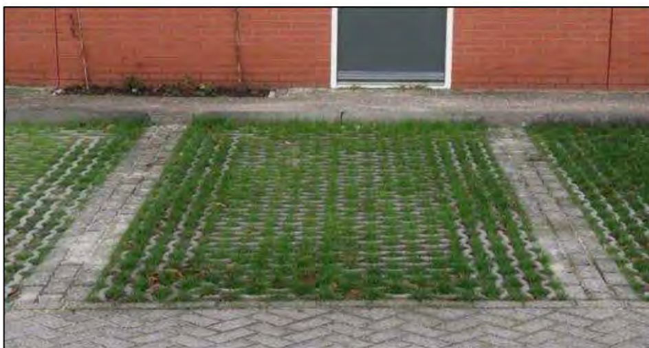
Figuur 8: Halfverharding bij parkeerplaatsen (bron:duurzaamdenhaag.nl).
